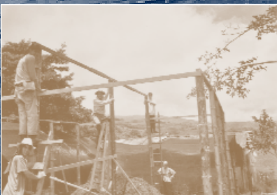
Construction au Costa Rica 2004
