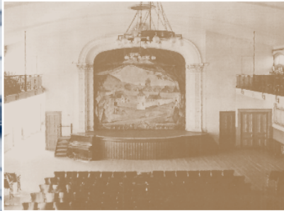
l'Ermitage avant le réaménagement de 1940.
